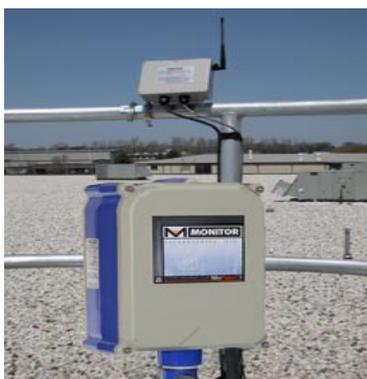
**SiloPatrol®** 重锤式料仓监测系（SMU）是一个基于坚固的钢缆结构的智能传感系统。实践证明该系统能够可靠应用于各种筒仓、储罐、储槽中的料位测量，
